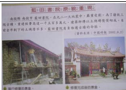
圖 145：四上社會課本講到土塢屋的維護仍然使用水泥感覺已經失去古蹟的味道應該使用和以前一樣的建材來整修
