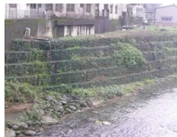
圖 148：高高的河岸生態工法蛇籠應該考慮用環保的建材加以鞏固才不會被水沖垮
