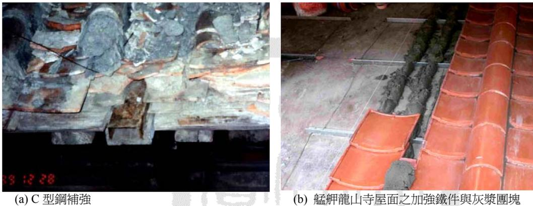
(a) C 型鋼補強
