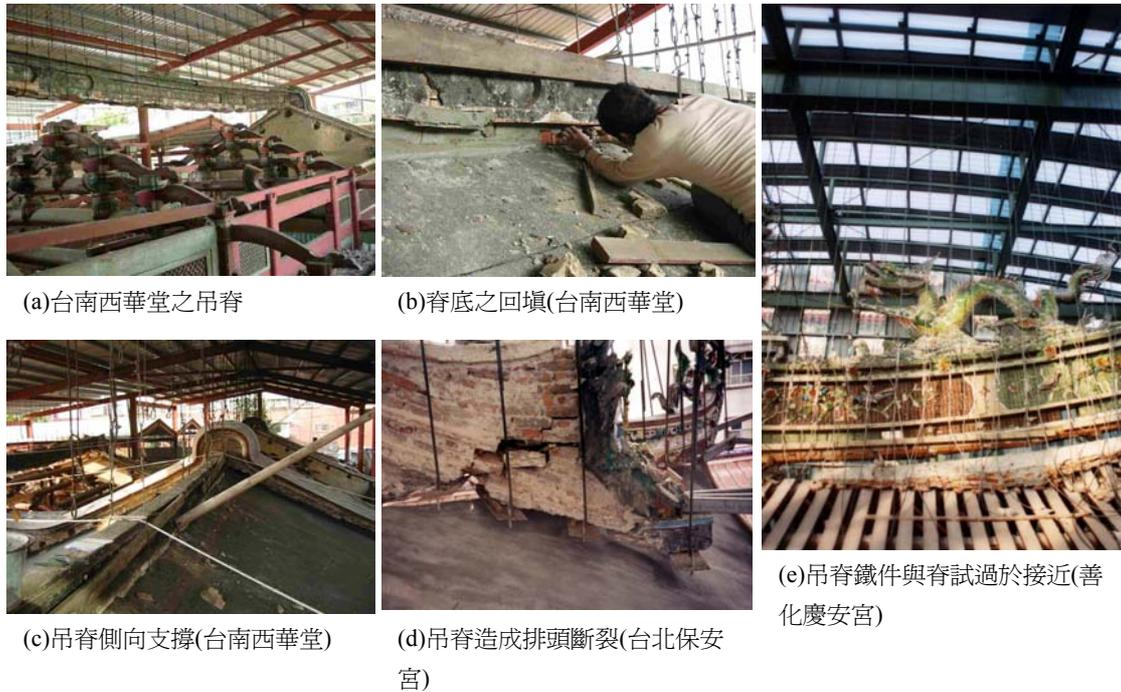
目的通常爲了維持建築的原有形態，並爲了保留屋脊上的裝飾物。此法應始於彰化孔廟之修復工程，至今台南天壇前殿的修復亦用此法，見圖 2-2.6。吊脊法最大的問題在於仍然無法維持屋脊原貌，原因除了工程進行必然的碰撞之外，剛性較大的圬工構造在搖晃的鋼索垂吊下經常發生裂痕甚至斷裂甚至倒落屋面。
