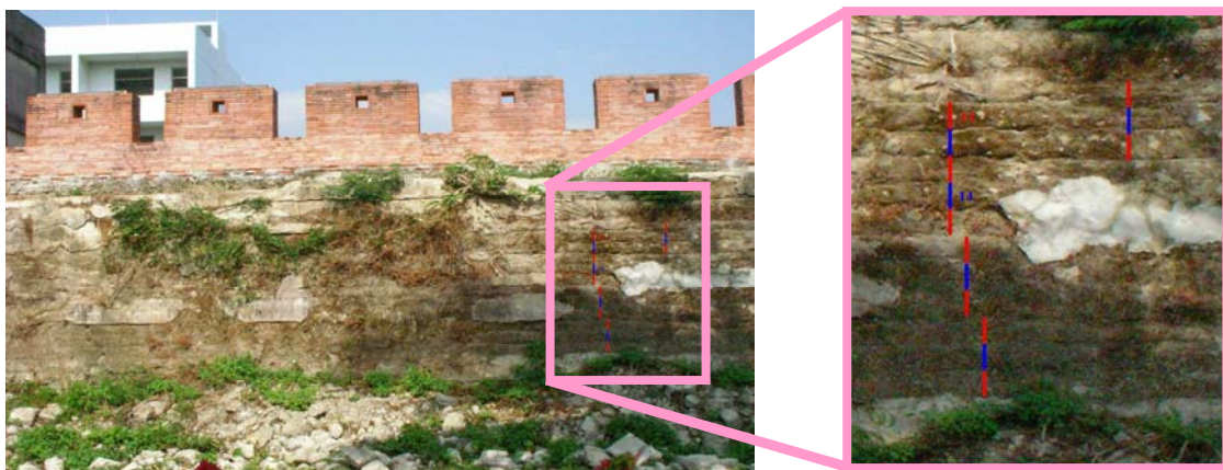
照片 4-13 恆春縣城北門段版築夯土牆
