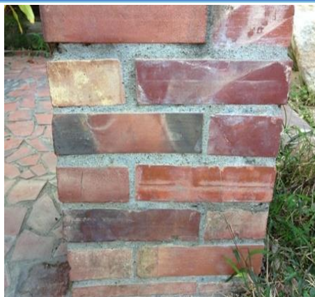
圍牆側面之砌磚方式與結構
