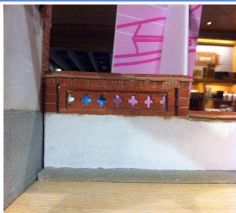
圍牆正面之砌磚方式與結構
